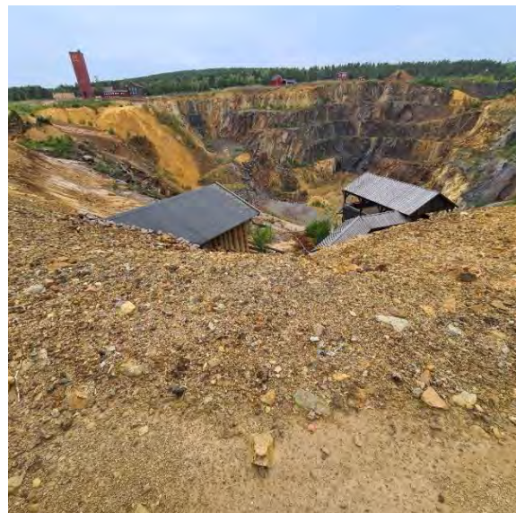
Blick in die eingestürzte Grube des Bergwerks
